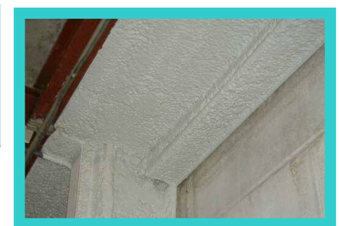
(封じ込め処理後)
