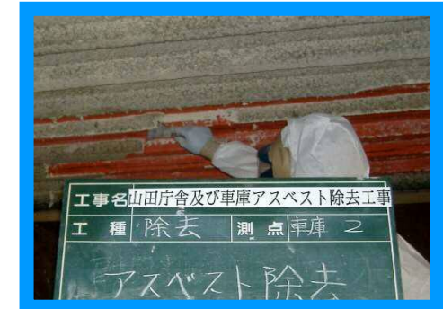
(アスベスト除去作業状況)
