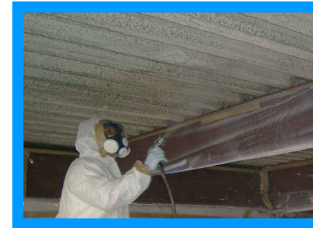
(飛散防止抑制剤吹付け状況)
